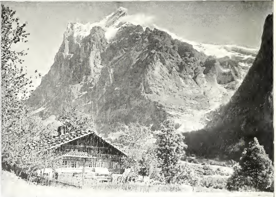
Abb. 92. Werner-Haus bei Grindelwald. Nach einer Photographie von Gebr. Wehrli in Kilchberg.
